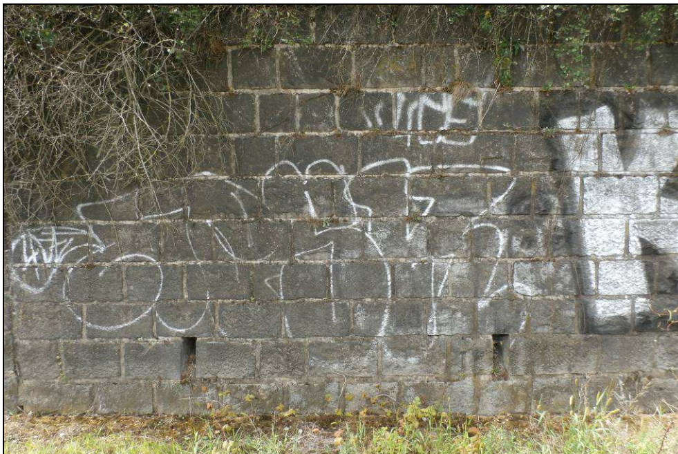
Obr. č. 6 - pohled na zárubní zeď - náletové rostliny a dřeviny uchycené ve spárách a na koruně zárubní zdi
