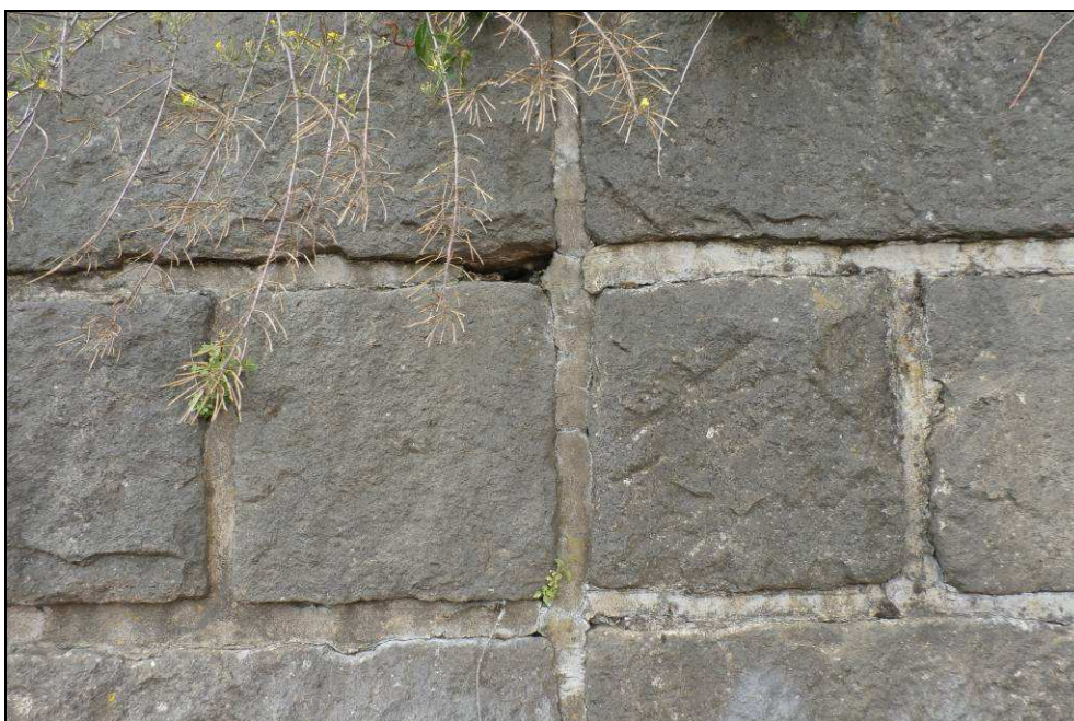
Obr. č. 5 - detail porušeného spárování v blízkosti dilatační spáry mezi zárubními zdmi
