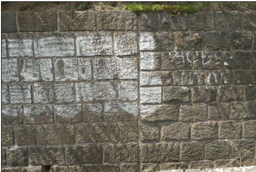
Obr. č. 4 - pohled na dilatační spáru
